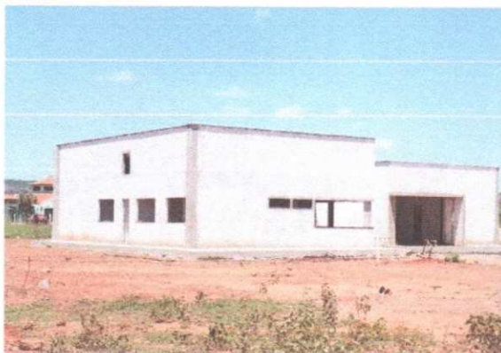
Foto 7: Prefeitura Municipal (em construção)
