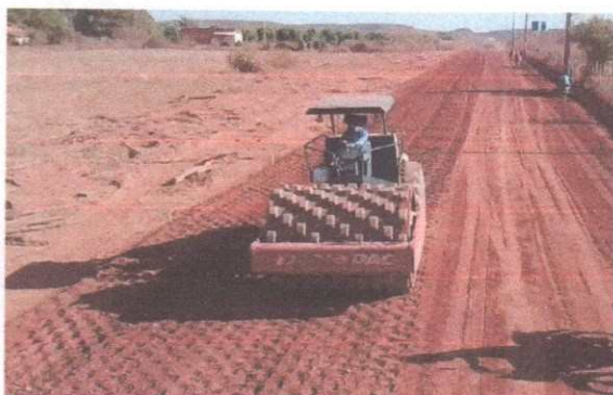
Foto 5: Pavimentação do acesso a Serra
