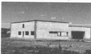
Foto 7: Prefeitura Municipal (em construção)
