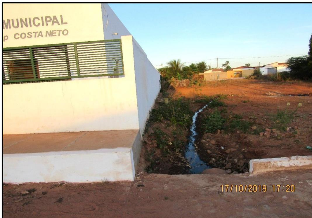
Figura 34 - Ponto de lançamento de esgoto na Sede de João Costa
