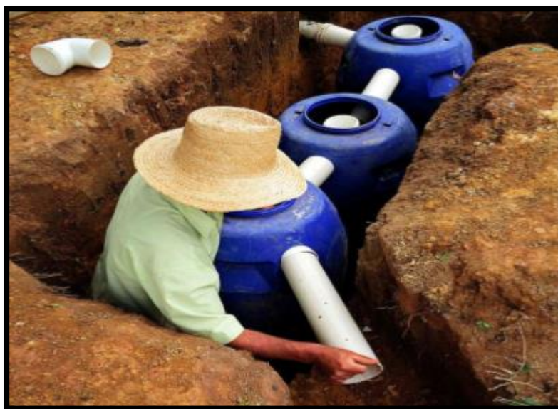
Figura 6 - Modelo de fossas sépticas econômicas Fonte: Fundação Banco do Brasil (2012)
