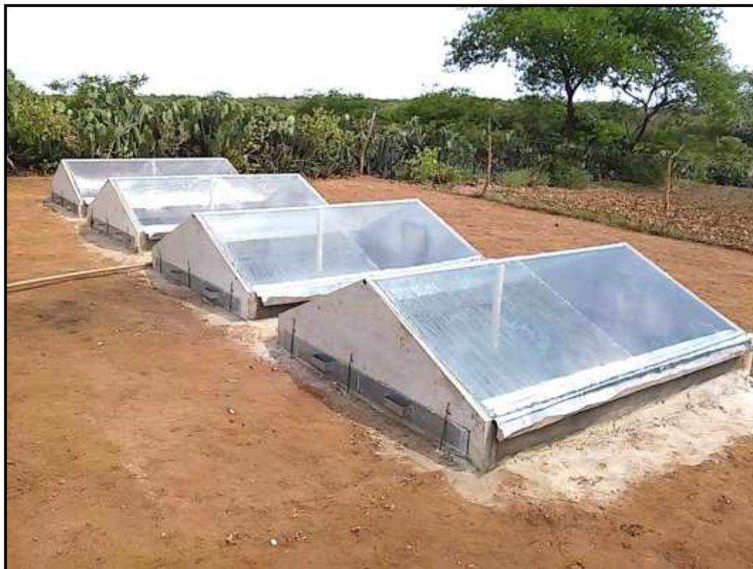
Figura 82 - Sistema de dessalinizadores solar Fonte: Fundação Banco do Brasil
