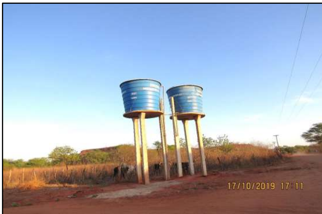
Figura 37 - Reservatórios públicos de 15.000 L de João Costa Fonte: NERAR ENGENHARIA (2019)
