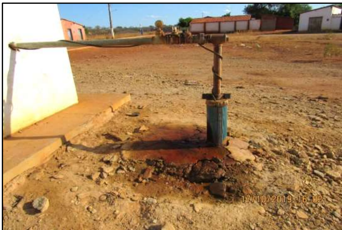
Figura 34 - Um dos Poços públicos existentes na Zona Rural de João Costa Fonte: NERAR ENGENHARIA (2019)
