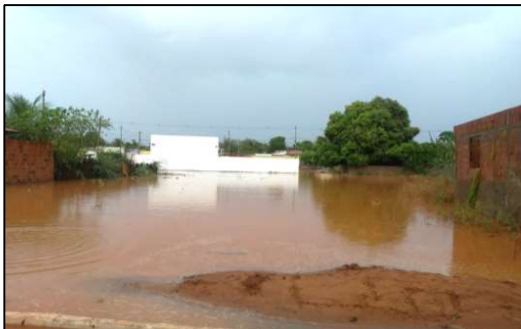
Figura 79 – Alagamento na Sede de João Costa (chuva do final do ano de 2019) Fonte: Grupo de Trabalho (2019)
