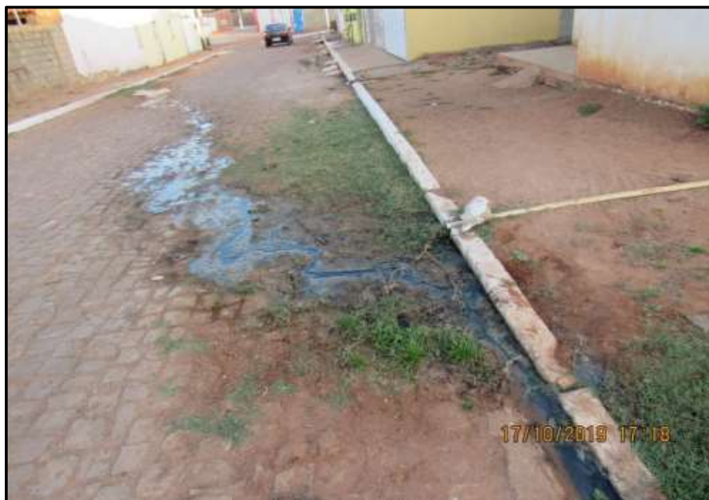
Figura 42 - Esgoto a céu aberto na Sede de João Costa Fonte: NERAR ENGENHARIA (2019)
