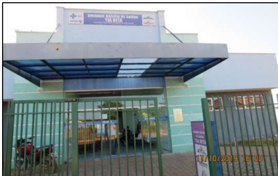
Figura 62 - UBS Tia Rita da Zona Rural do município de João Costa Fonte: NERAR ENGENHARIA (2019)
