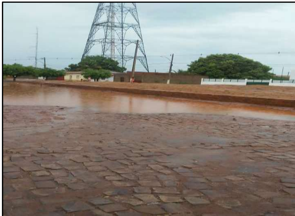
Figura 72 – Ponto crítico na Sede de João Costa (chuva do final do ano de 2019) Fonte: Grupo de Trabalho (2019)
