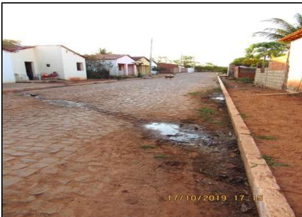
Figura 40 - Esgoto a céu aberto na Sede de João Costa Fonte: NERAR ENGENHARIA (2019)
