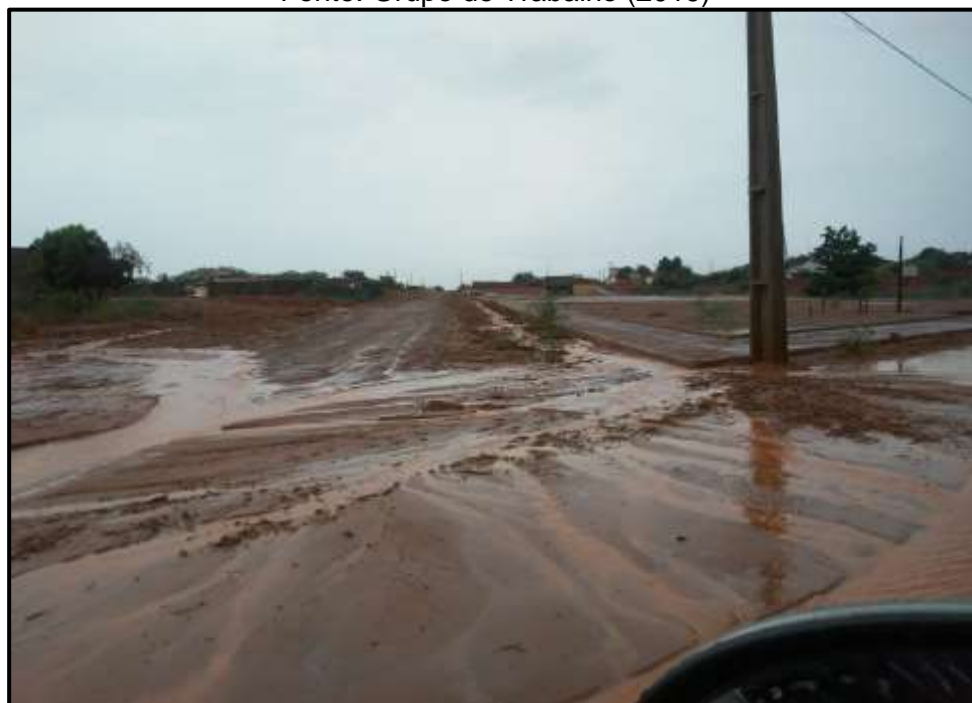
Figura 75 – Alagamento na Sede de João Costa (chuva do final do ano de 2019) Fonte: Grupo de Trabalho (2019)
