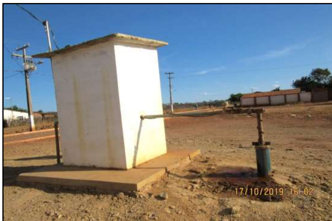
Figura 33 - Um dos Poços públicos existentes na Zona Rural de João Costa Fonte: NERAR ENGENHARIA (2019)
