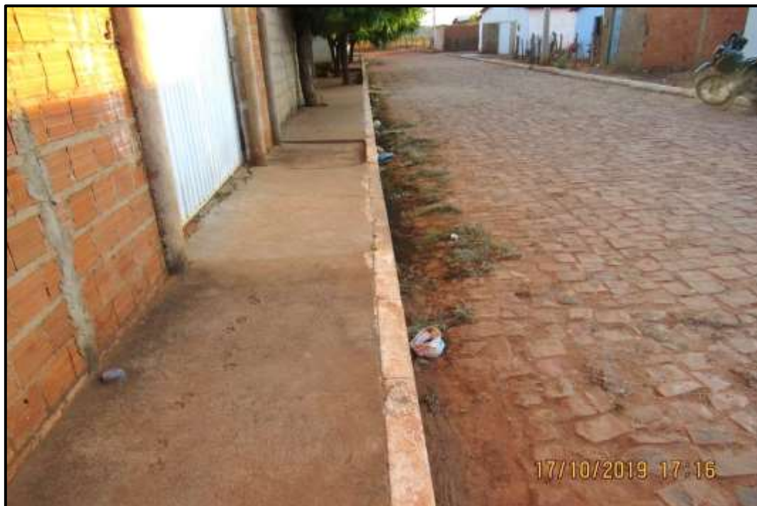
Figura 44 - Esgoto a céu aberto com presença de lixo na Sede de João Costa Fonte: NERAR ENGENHARIA (2019)
