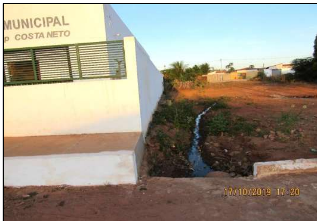
Figura 43 - Ponto de lançamento de esgoto na Sede de João Costa Fonte: NERAR ENGENHARIA (2019)
